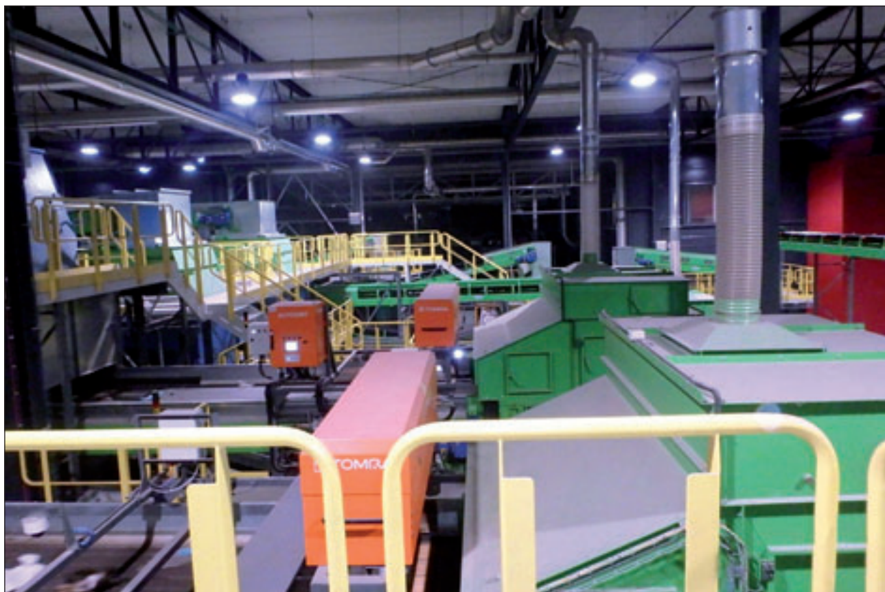
Regionalny Zakład Zagospodarowania Odpadów Promnik
