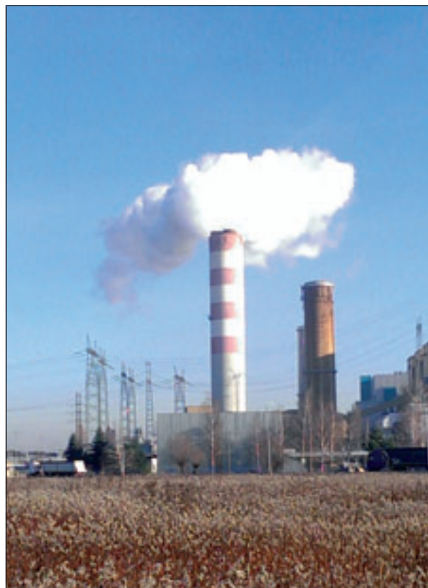
Para wodna z instalacji odsiarczania spalin metodą mokrą w Elektrowni w Połańcu
