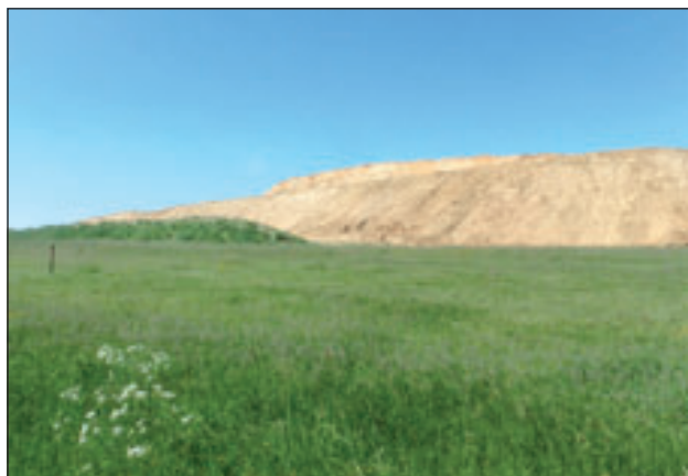
Zwałowisko nadkładu wraz z wałem ochronnym przy kopalni dolomitu Janczyce
