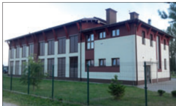
Oczyszczalnia ścieków komunalnych w Solcu-Zdroju
