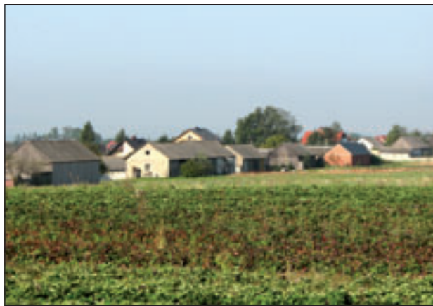
Azbestowe pokrycia dachowe w gminie Górno
