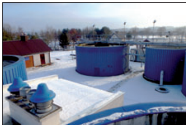
Oczyszczalnia ścieków komunalnych w Stykowie (gm. Brody)
