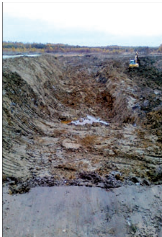
Budowa kolejnej kwatery na składowisku Dobrów
