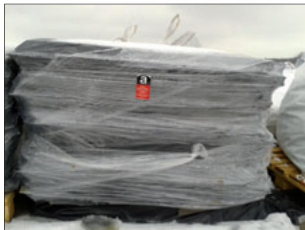
Zdemontowane, zabezpieczone i oznaczone płyty azbestowe
