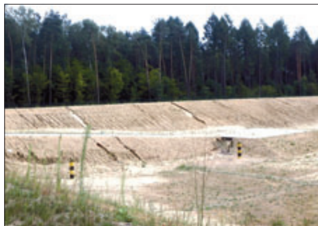
Budowa nowej kwatery na składowisku Janik
