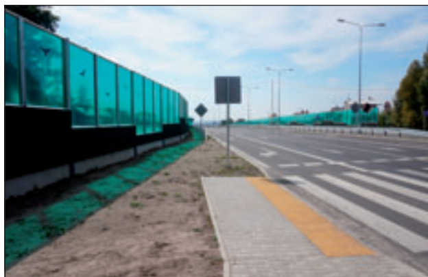
Ekran akustyczny przy ul. Ściegiennego w Kielcach
