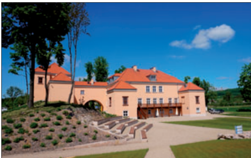
Regionalne Centrum Naukowo-Technologiczne w Podzamczu Chęcińskim
