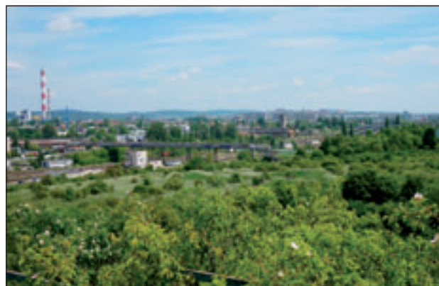
Kielce – część przemysłowa (w tle Elektrociepłownia Kielce)
