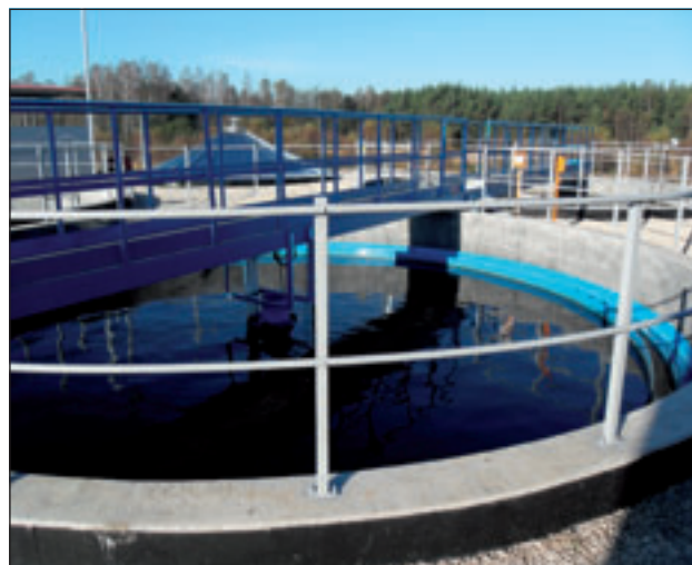
Oczyszczalnia Ścieków Komunalnych w Krasocinie
