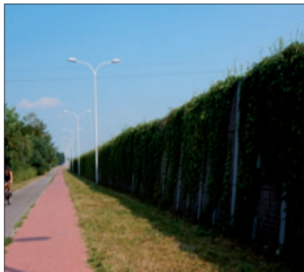
Ekran akustyczny przy ul. Krakowskiej w Kielcach
