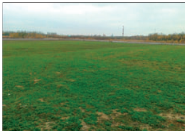
Widok na składowisko odpadów niebezpiecznych – etap I rekultywacji, wprowadzono zieleni niską i teren jest przygotowywany pod nasadzenia zieleni wysokiej
